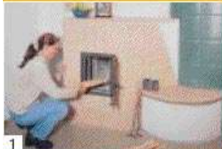
1 Holz im Brennraum kreuzweise aufschichten und die Luftzufuhr öffnen.
